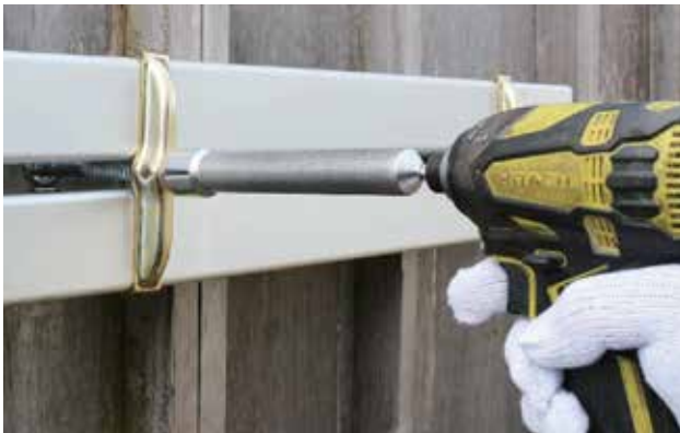
●電動工具で型枠組立・脱型作業がスピードアップ
